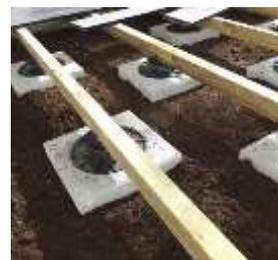
Afin d'éviter la formation d'un point de rosée au dos de vos lames de terrasses, Il est important de désolidariser la structure du support avec de petites cales plastique de 3 à 10 mm afin de permettre un parfait écoulement des eaux. En respectant ces simples consignes vous éviterez : - Un tuilage excessif des lames, un fendillement de celles-ci , l'apparition de gerces.
