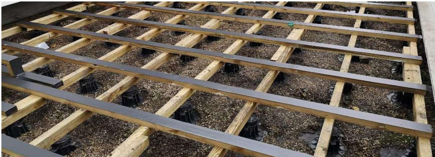
Etapes de la réalisation d'une surface adaptée à recevoir une terrasse bois : - Décaisser le sol sur 10 cm (décaper la terre végétale et enlever les éventuelles mottes de gazon), - Rapporter au moins 10 cm de gravier pour drainer la surface. Régler la planéité du sol grâce à une règle en ménageant une légère pente (1 cm / m) en direction du terrain pour favoriser l'écoulement des eaux de pluie. Tasser l'ensemble pour obtenir une portance minimale d'environ 2 bars (utiliser une plaque vibrante).
