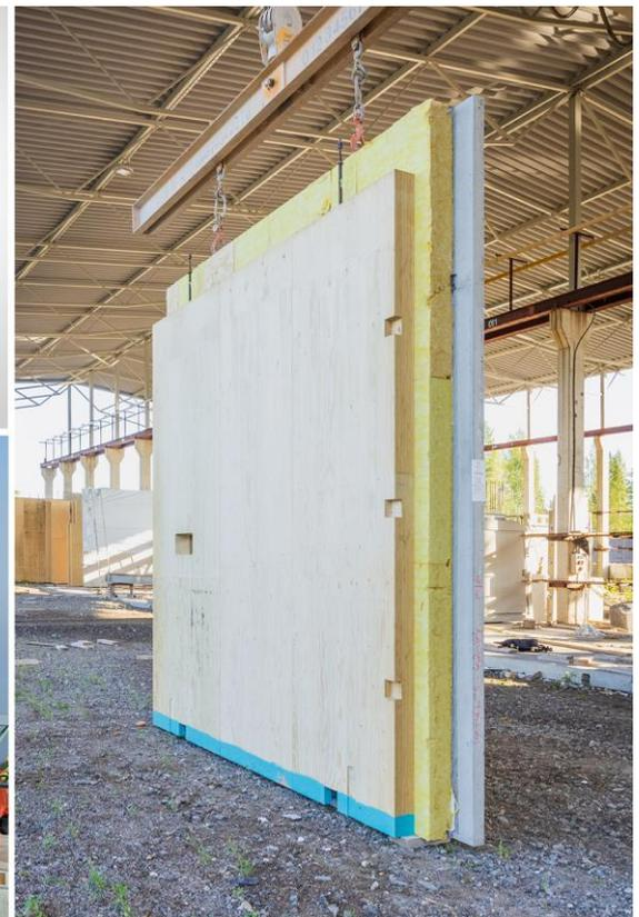
Pour les entreprises de construction, la méthode hybride offre une plus grande durabilité, sans modifier leurs pratiques actuelles. Metsä Wood et ses partenaires ont conçu un élément de mur sandwich hybride qui révolutionnera la construction hors-site. Cette innovation associe le béton au Kerto® LVL. La légèreté de ces éléments de murs sandwich hybrides a constitué un précieux avantage dans le premier projet de construction de la scierie Metsä Fibre de Rauma.
