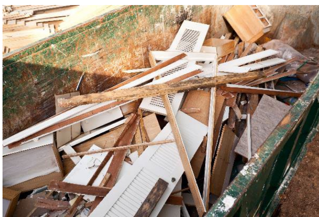
Crédit photo : Ecomaison - Benne avec les déchets du BTP
